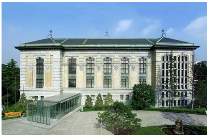
Fot. 1. Widok budynku od frontu
