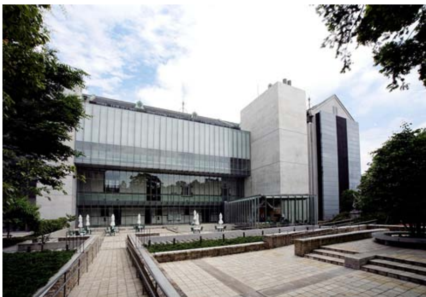
Fot. 3. Widok budynku od tyłu. Lekka konstrukcja i szklane tafle nowoczesnej dobudowy zapewniają możliwość zobaczenia oryginalnej elewacji budynku.
