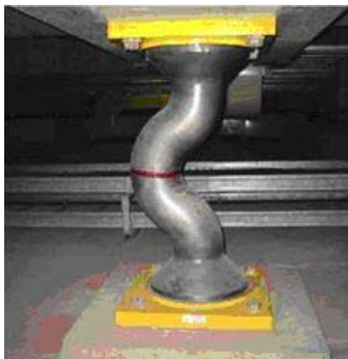
Fot. 2. Sejsmiczne izolatory zainstalowane pod budynkiem biblioteki
